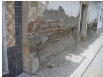
**Figura 7** - Exemplo de edifícios com patologia muito grave ao nível das paredes exteriores
