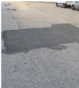
**Figura 37** - Pavimentos irregulares, derivado a várias intervenções
