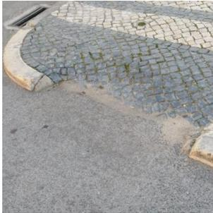
**Figura 34**– rebaixamento do pavimento para pessoas com mobilidade condicionada
