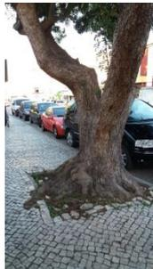
**Figura 35** - Pavimentos irregulares e destruídos devido à ação das raízes das árvores
