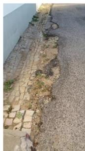
**Figura 38** - Transição entre pavimentos mal executada.
