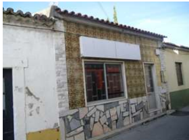
Figura 6 - Edifício com elementos dissonantes
