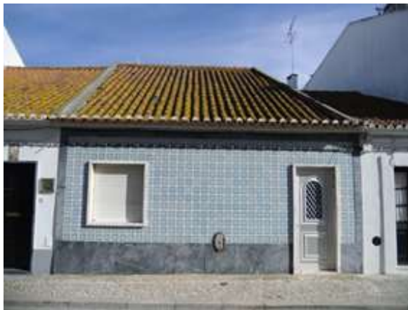
Figura 5 – Edifício com elementos dissonantes
