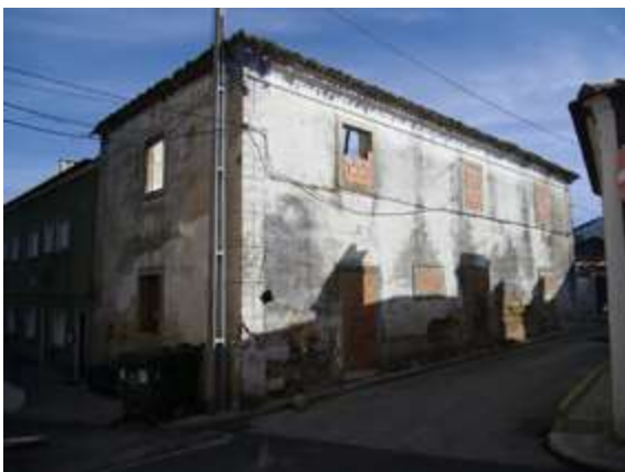
Figura 1 - Edifício devoluto na Rua do Norte
